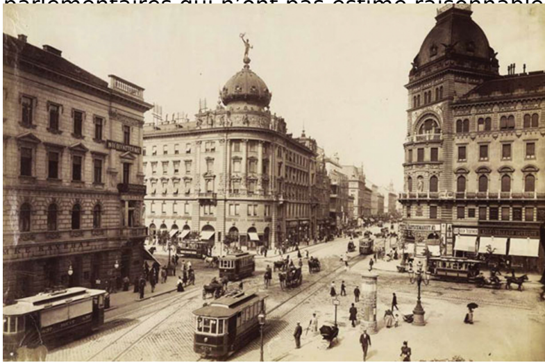
A la place, la construction du Grand
